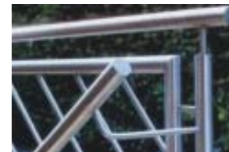
Detail eines Geländers
